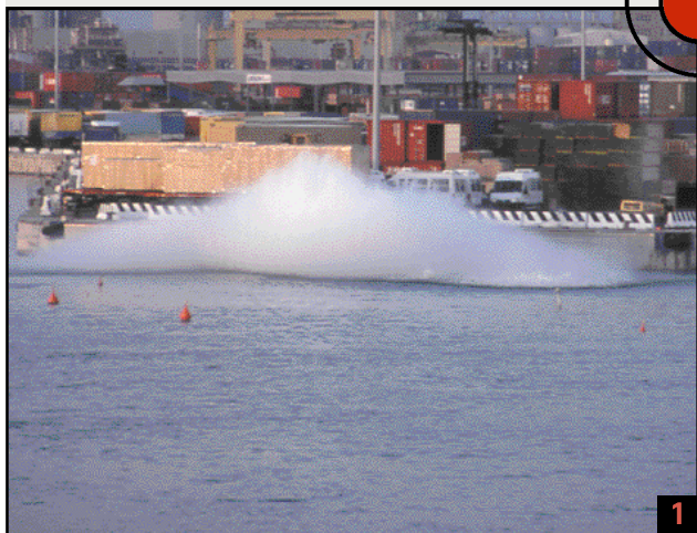
figura 1 Brillamento della volata a ridosso della banchina
